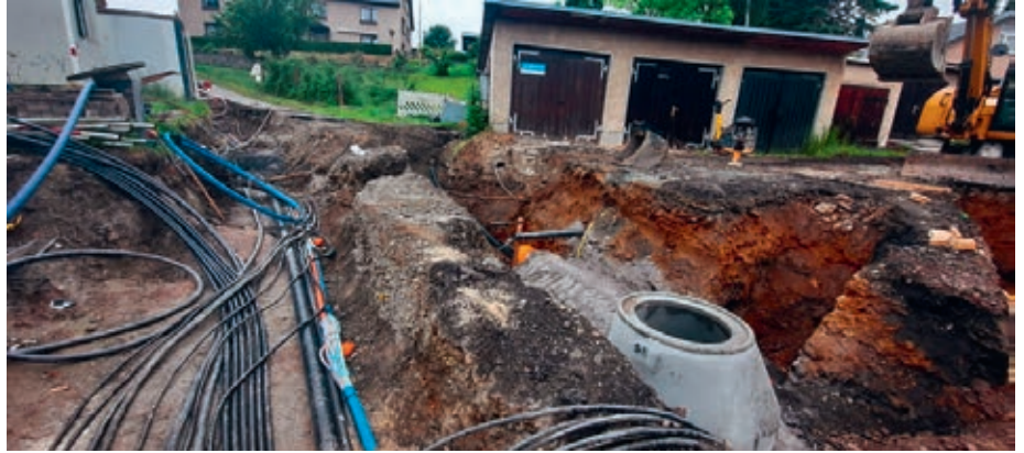
Situation Baustelle Adlerweg Crottendorf OT Walthersdorf
